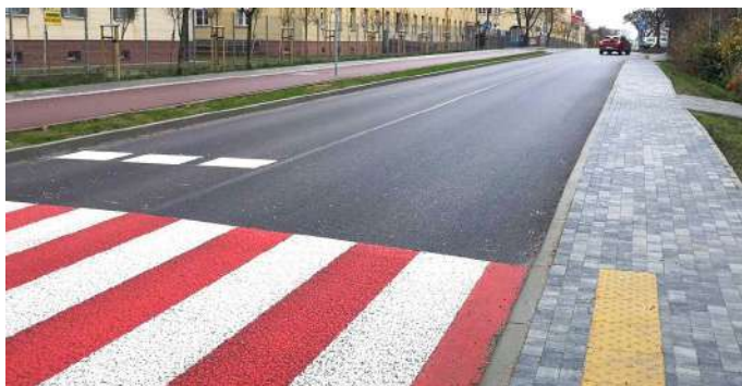
Nowy chodnik, nowa nawierzchnia, Nowowiejska - po prostu
