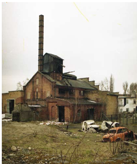
Gazownia miejska przed rozbiórką
