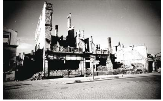
Zniszczony budynek przy zbiegu rynku i ul. Królewieckiej
