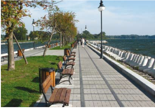
Giżyckie moło po przebudowie
