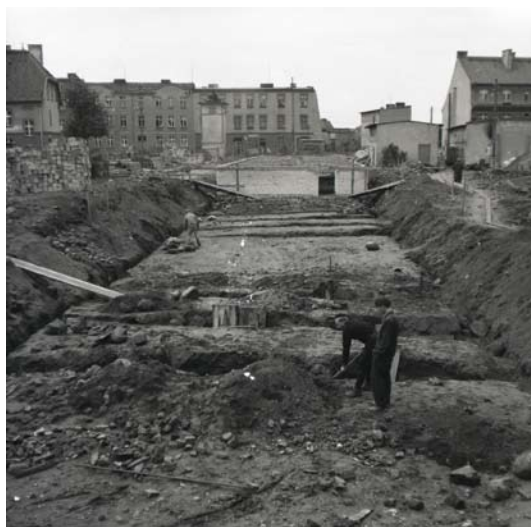
Budowa przy ul. I Dywizji im. T. Kościuszki
