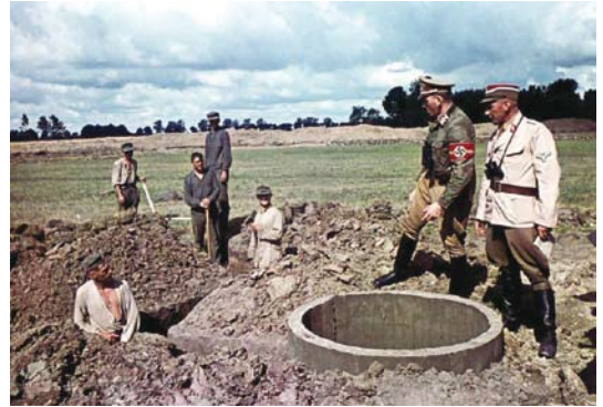
Budowa umocnień, Prusy Wschodnie, lipiec 1944 r.
