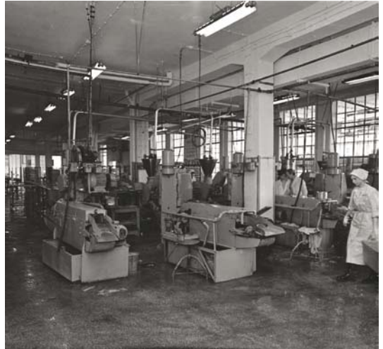
Hala produkcyjna Zakładów Rybnych w Giżycku, lata siedemdziesiąte
