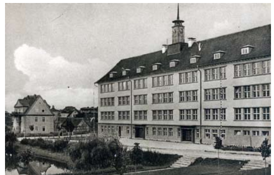
Lutherschule po zakończeniu budowy
