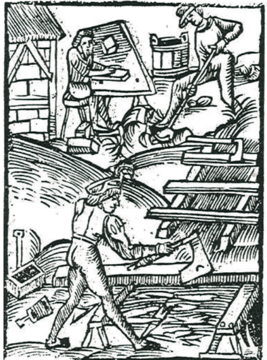
Cieśla przy pracy
