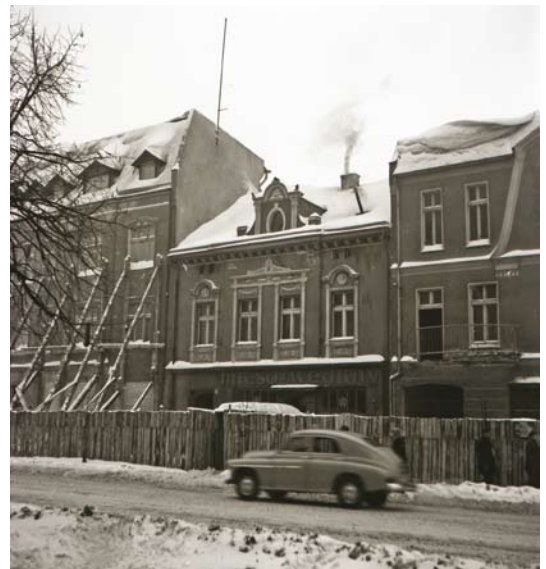
Rozbiórka domów na ul. Warszawskiej, 1967 r.
