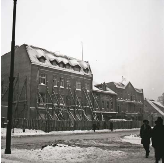
Rozbiórka domów na ul. Warszawskiej, 1967 r.
