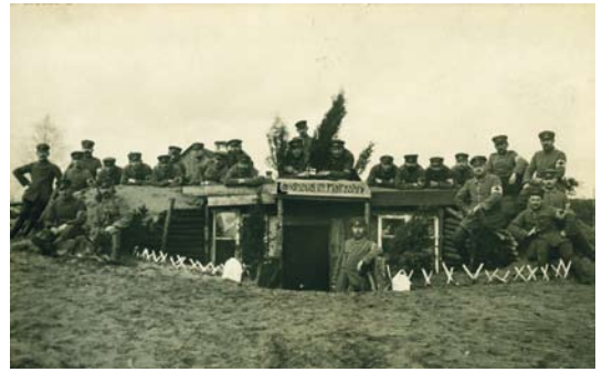
Niemiecki punkt sanitarny
