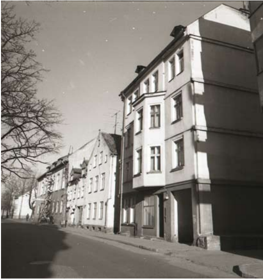
Budynki przy ul. Konarskiego, które, mimo przeznaczenia do rozbiórki, przetrwały aż do lat dziewięćdziesiątych
