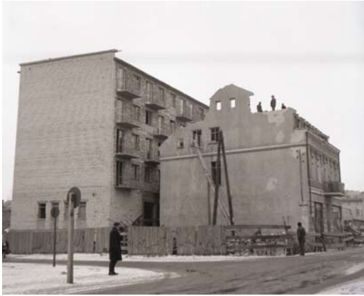
Budowa bloku przy ul. Olsztyńskiej, 1967 r.
