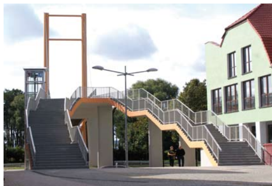
Kładka na pasażu portowym
