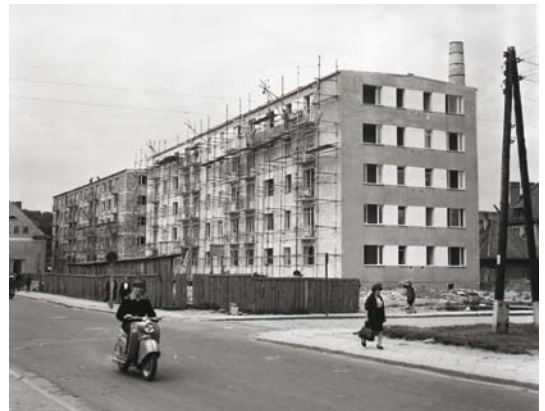
Budowa bloku przy ul. Olsztyńskiej, 1967 r.
